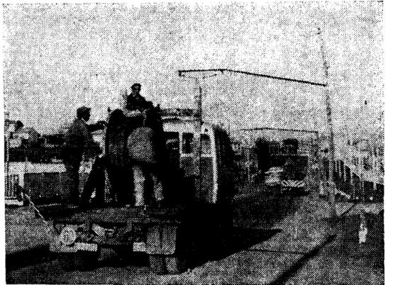
En la carretera de Carballo se está procediendo a la retirada del cable del tendido eléctrico que hasta hace poco utilizaban los trolebuses de la línea Carballo - La Coruña...
