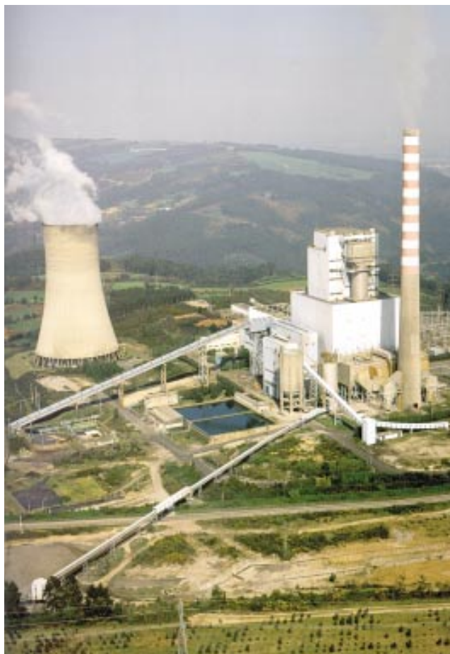
Figura 5.8. Central Térmica de UNIÓN FENOSA en Meirama
